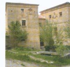
📍 Casa-palacio con dos torres en Cortiguera.
